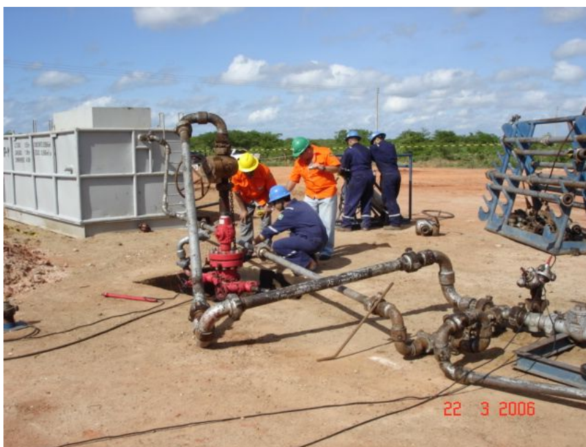
Figura 6 – Poço de Petróleo Pronto para Receber o Fraturamento Hidráulico, Local: Mossoró-RN (Foto: Santos, J.S.)
