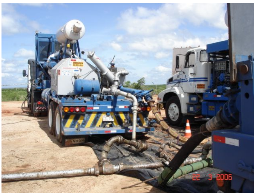
Figura 7 – Equipamentos Utilizados no Fraturamento Hidráulico de Poço de Petróleo, Local: Mossoró-RN (Foto: Santos, J.S.)
