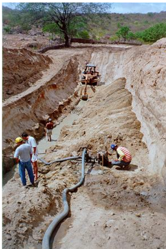
Figura 1 - Abertura da vala
