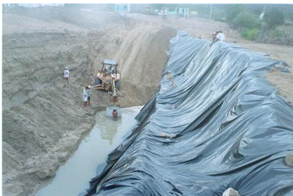
Figura 2 - Implantação do poço e da lona plástica
