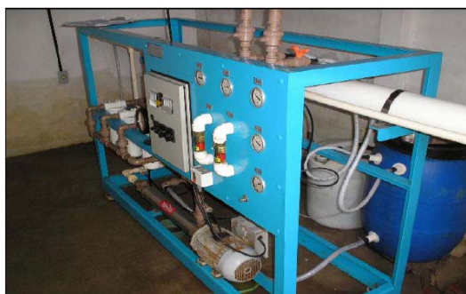
Figura 4 – Sistema de dessalinização estudado
