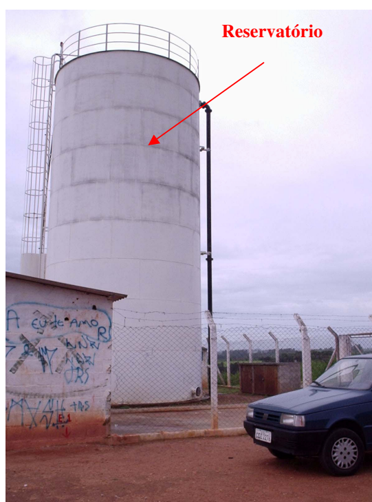
Figura 6. Reservatório do SAAE localizado no Conjunto 22 Abril.
