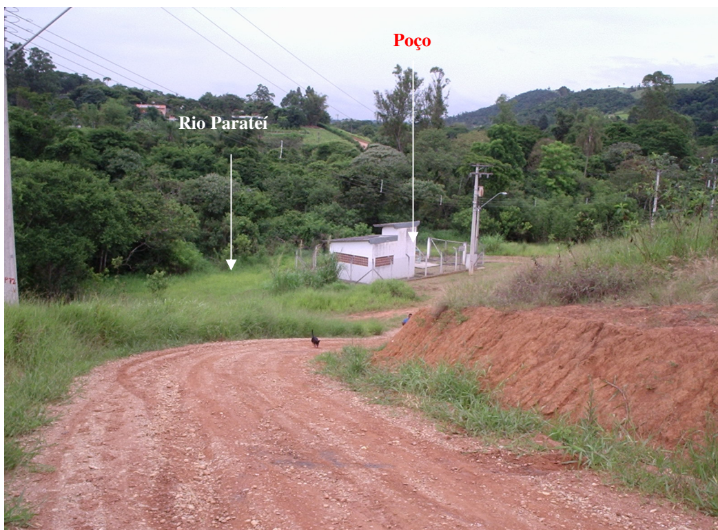
Figura 3. Poço do SAAE no Conj. 22 Abril (vista 1).
