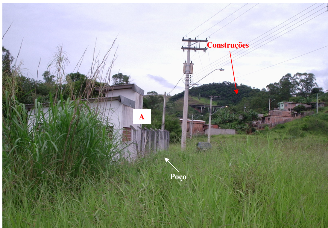
Figura 5. Localização do poço do SAAE em relação às construções do Conj. 22 Abril.
