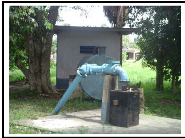
Figura 04- Poço tubular que capta água do sistema aquífero Barreiras utilizado para abastecimento público da região de Barcarena/PA (Fonte: Almeida, 2005)
