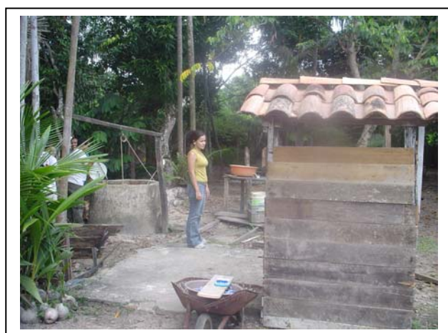
Figura 25 – Proximidade entre um sanitário que despeja os dejetos humanos diretamente no solo e o poço escavado, em Barcarena/PA. (Fonte: Prado, 2006)
