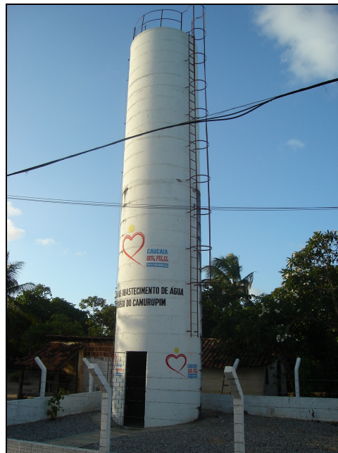
Figura 12 – Poço nº 133 localizado na comunidade Camarupim, Caucaia – Ceará (Foto em 29/11/2006)
