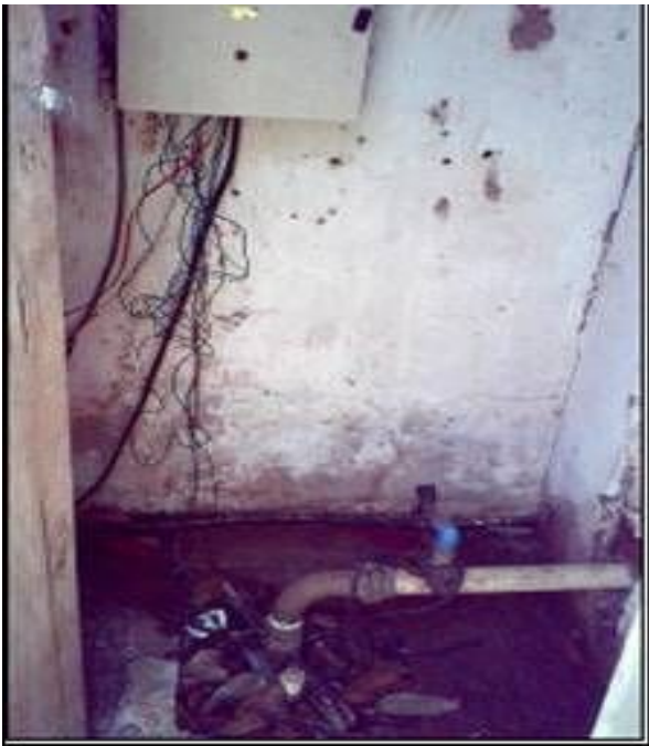
i.e. Figura 8 - Poço do Chicó.
