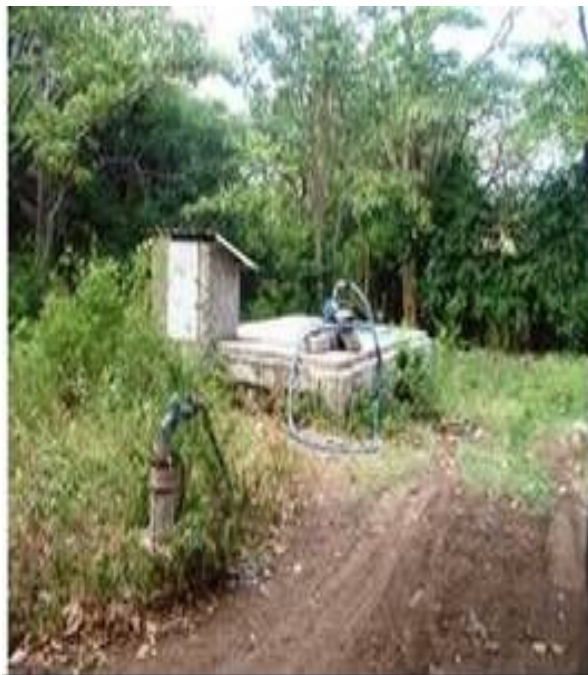
i.e. Figura 5 – Poço Caieria
