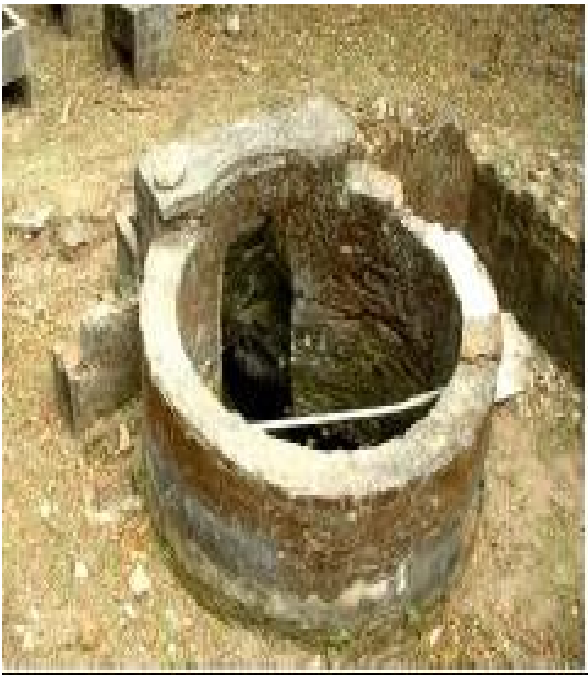
i.e. Figura 3 - Casa de Banho
