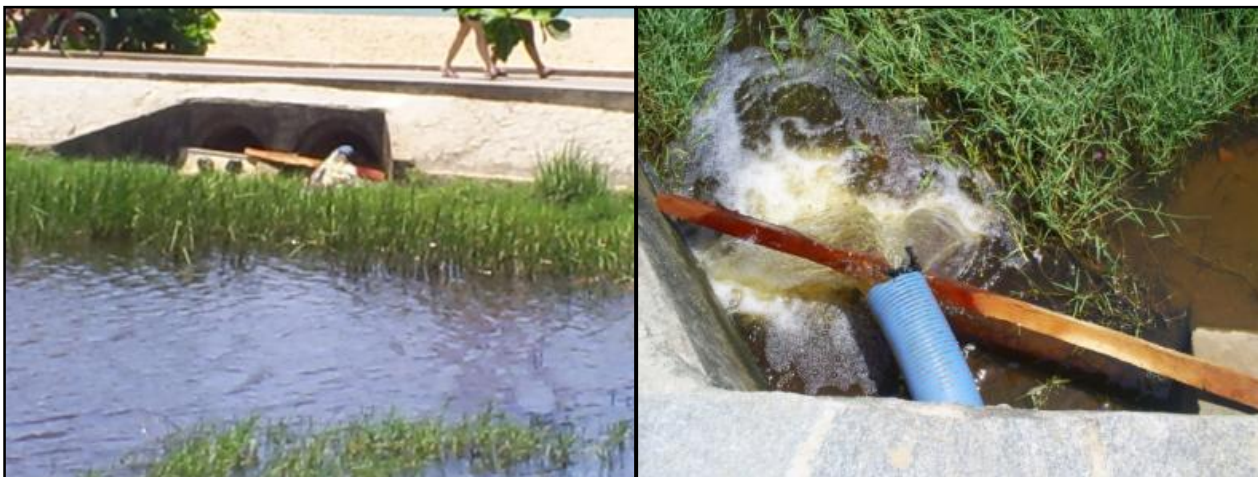
Figura 8 - Ponto de lançamento da água de rebaixamento do lençol freático na lagoa. (FONTE: Arquivo pessoal)
