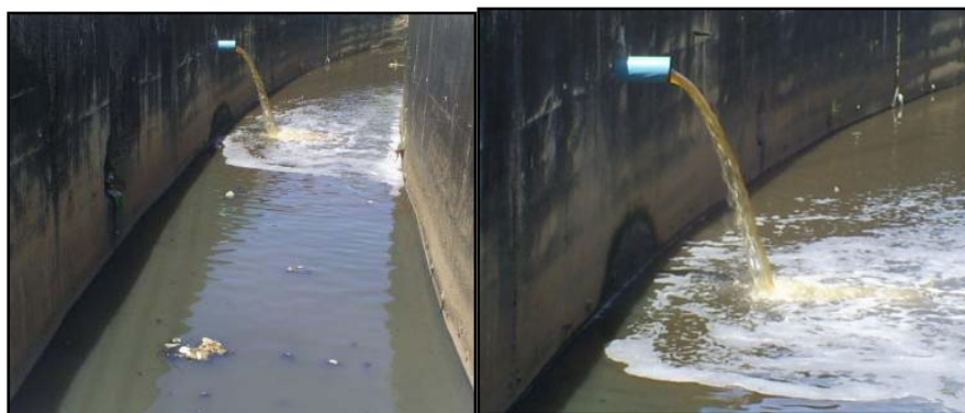
Figura 10 – (a) Águas provenientes do rebaixamento do lençol lançadas no Riacho do Sapo. (b) Detalhe do lançamento. (FONTE: Arquivo pessoal)
