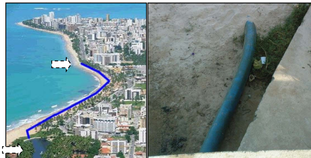
Figura 7 – (a) Distância entre o ponto onde está ocorrendo o rebaixamento do lençol e a lagoa onde a água está sendo lançada. [11] (b) Tubulação condutora da água de rebaixamento. (FONTE: Arquivo Pessoal)
