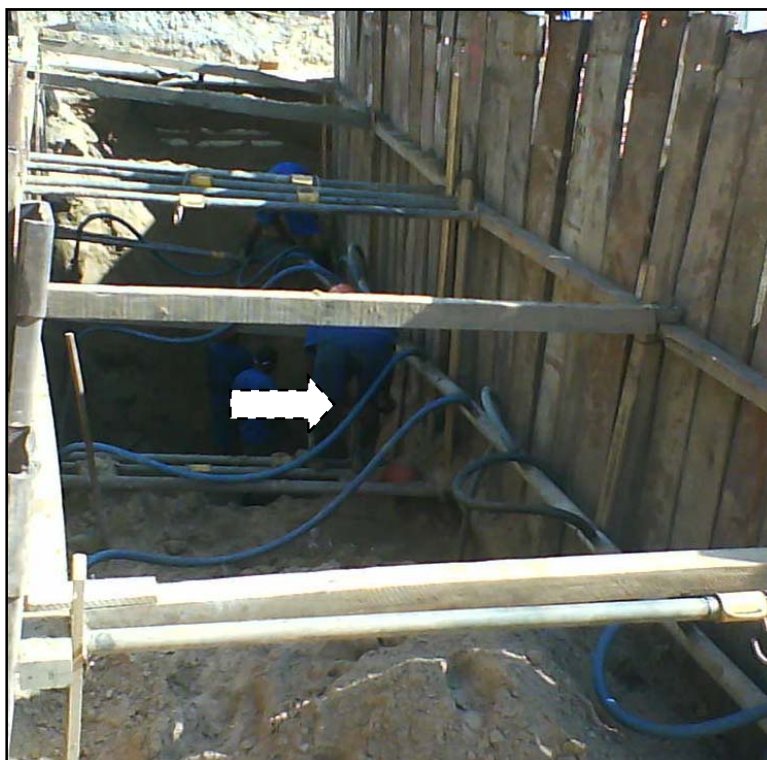
Figura 1 - Detalhe das ponteiros utilizadas para rebaixamento do lençol na construção de um edifício na Ponta Verde. (FONTE: Arquivo pessoal)
