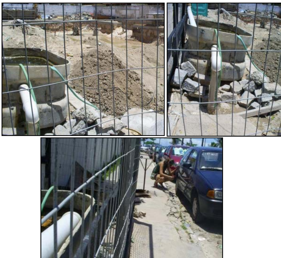
Figura 12 - Coleta e lançamento da água subterrânea proveniente de rebaixamento de aquífero (FONTE: Arquivo pessoal)
