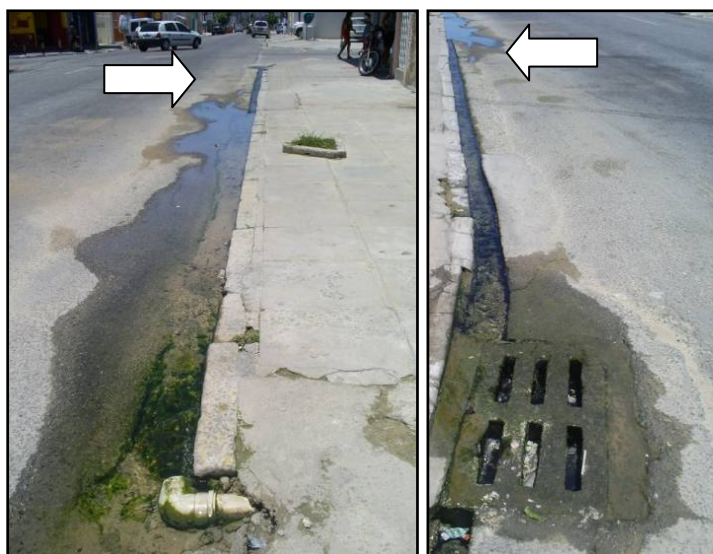
Figura 4 - (a) A seta indica onde está o lançamento da água na rua e a sinalização de onde está sendo lançada a água na rede pluvial, enquanto que na figura (b) observa-se a continuidade da trajetória da água até a sarjeta onde está sendo despejada a água. (FONTE: Arquivo pessoal)
