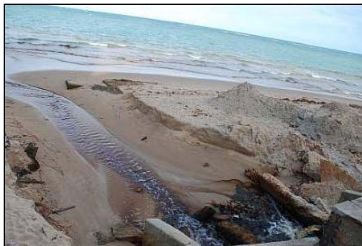
Figura 6 - Lançamento da água resultante do rebaixamento do lençol freático na praia de jatiúca. [13]
