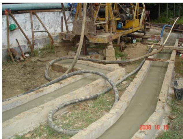
Foto 1 – Perfuração do Poço de Filtração nas Margens na ETA Caixa D'água.
