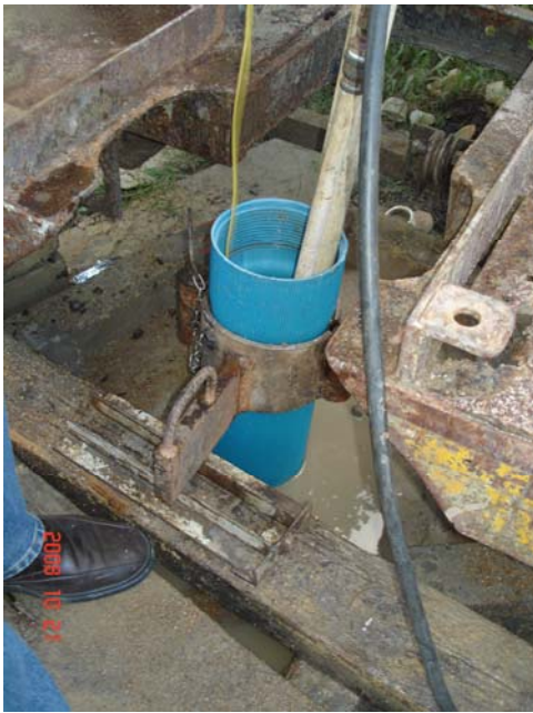
Foto 2 – Instalação do Poço de Filtração em Margem.
